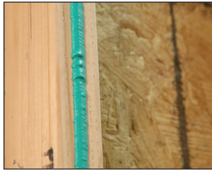
Stud Face to Drywall Gasket
